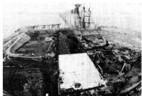
1月12日拍摄的三峡工程三期围堰基坑全景。三峡工程三期碾压混凝土围堰为一级临时挡水建筑物,全长约580米,堰顶高程140米。它与下游土石围堰一起保护右岸大坝、电站厂房及右岸非溢流坝段的施工,是实现三峡工程蓄水、通航、发电的控制性工程。
